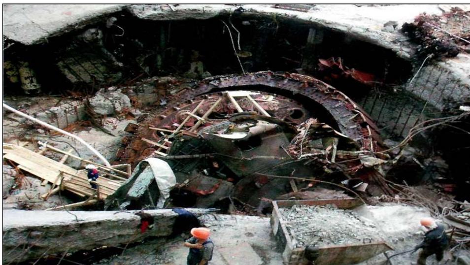
Рис. 5. Разрушения от динамических нагрузок фундаментных конструкций ГА-2 при его разгоне и подъёме и плиты перекрытия на отметке 327,0 м
