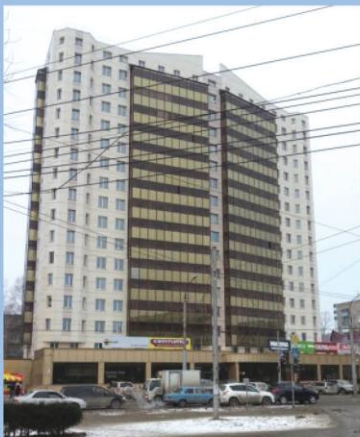
Рис. 1. Общий вид здания
