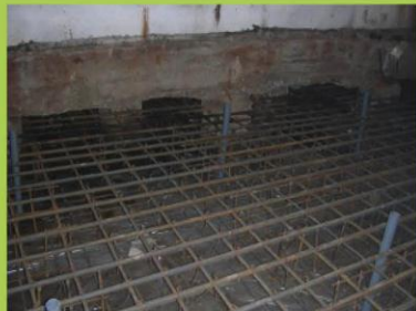
Рис. 2. Арматурный каркас с инъекторами для закрепления грунтов
