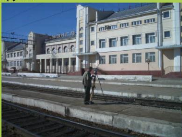
Рис. 1. Общий вид сооружения
